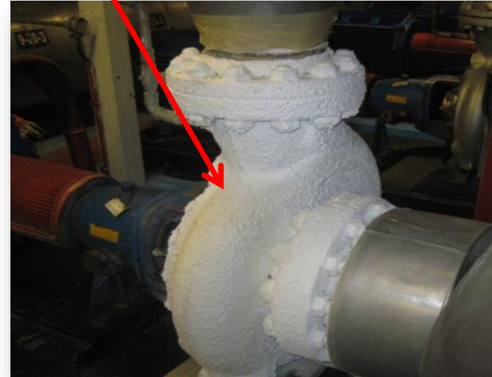
KIZGIN SU SİRKÜLASYON POMPASI KIZGIN SU SİRKÜLASYON POMPASI UYGULAMA ÖNCESİ DEĞERLER
